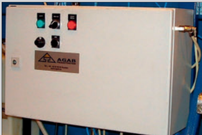
Elskåp med smörjprogram Electric cabinet with lubeprogram Schaltkasten mit Beölungsprogramm
